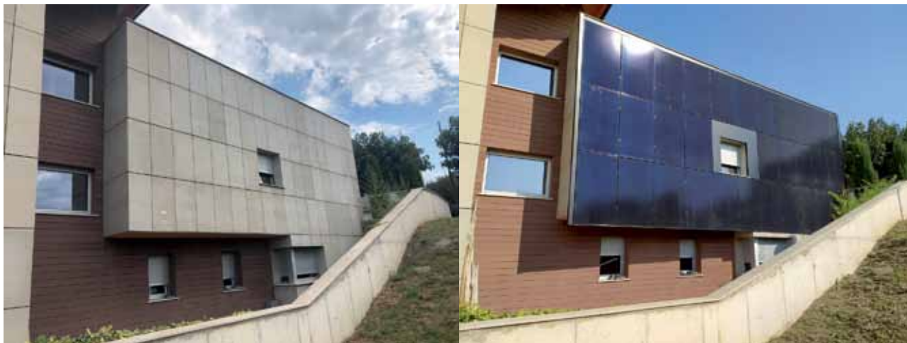
Antes y después de la instalación.
