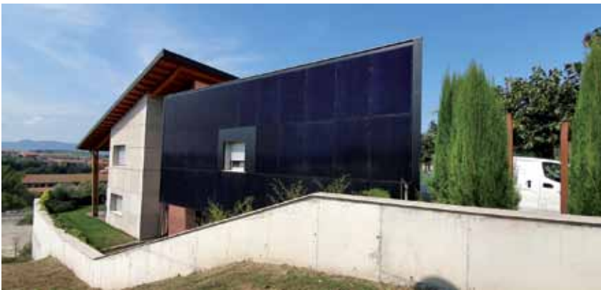
Vivienda en Roda de Ter con fachada fotovoltaica.
